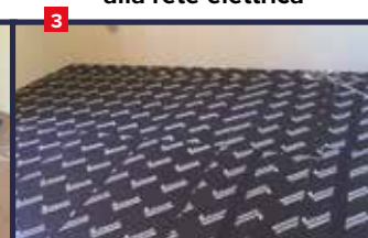
Collega l'ultimo modulo alla rete elettrica
