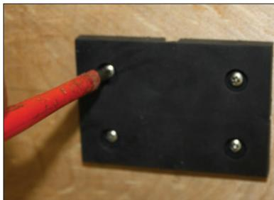
Immagine #1. Fissaggio dell'AV Pad ad una superficie verticale
