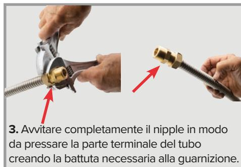
3. Avvitare completamente il nipple in modo da pressare la parte terminale del tubo creando la battuta necessaria alla guarnizione.
